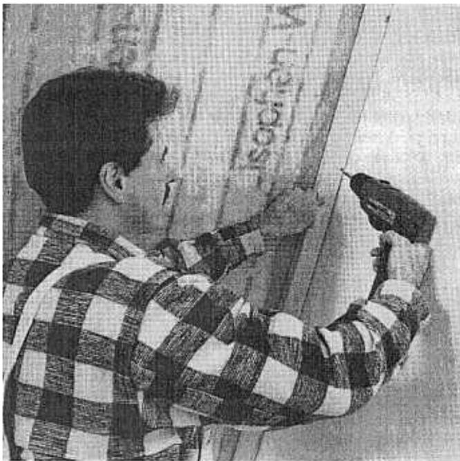
Bild 6. Bearbeitung eines Wandanschlusses mit Kompriband und Anpreßleiste auf einer Versuchsbaustelle
